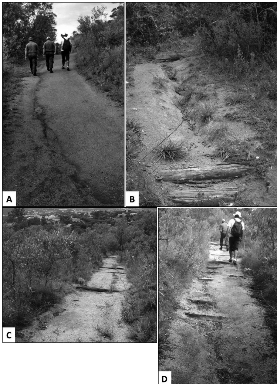
Figura 6 – Focos de processos erosivos em quatro pontos diferentes no Morro do Osso, normalmente associados à circulação de pedestres. As fotos B a D mostram o manejo para contenção da erosão (colocação de troncos perpendiculares à trilha)
