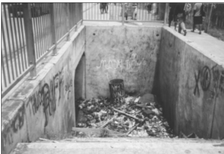
Foto 2 - Passagem de pedestre, cruzando a rua principal de Honiara, construída com fundos provenientes de uma agência internacional
