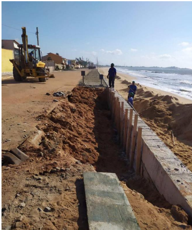
Figura 5: Obra de contenção da erosão costeira no Distrito de Tamoios, Cabo Frio.
