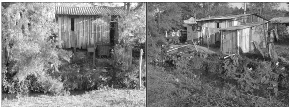
Figuras 9 - Moradias situadas nas margens do arroio Cancela sujeitas a processos de inundação e de erosão de margem – Vila Urlândia
