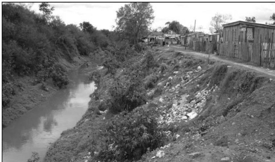
Figura 6 - Moradia que está em risco médio e alto de erosão de margem – Vila Lídia
