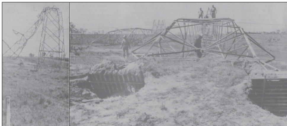
Figura 2 – Dano (a) e Queda (b) de Torres da Linha Jupuíá Campo Grande – Episódio ACL (15.10.1992)
