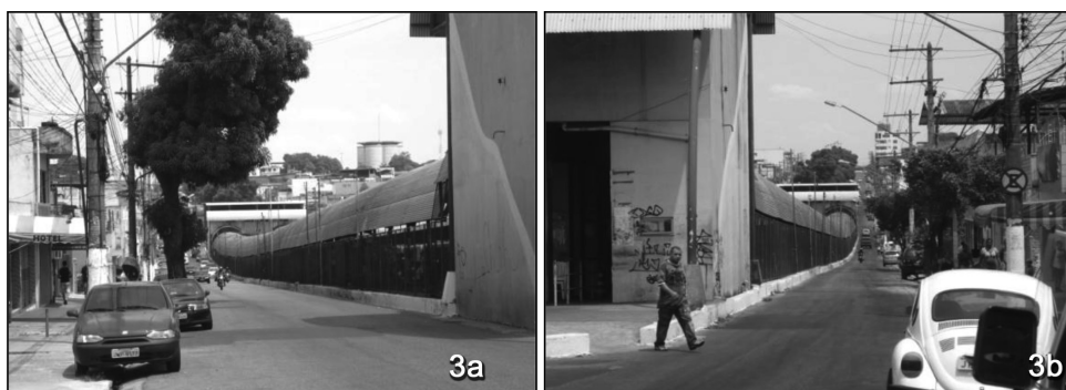
Figura 3a - (entrada centro-bairro: vista lateral esquerda) e Figura 3b - (entrada centro-bairro: vista lateral direita). Terminal 1 Constantino Nery
