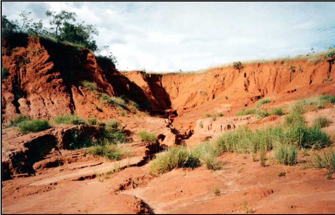
Figura 4: Espetacular voçoroca que evoluiu em terras do município de Prata (entrada do Pontal do Triângulo Mineiro), num demonstrativo ímpar de uma típica ulceração dos tecidos ecológicos, com perdas de solo afetando sobremaneira as cabeceiras de mananciais importantes na área.
