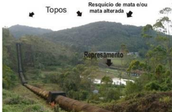
Foto 1. Desnível existente entre topo e talvegue e os usos do solo. (Flores, 2008).
