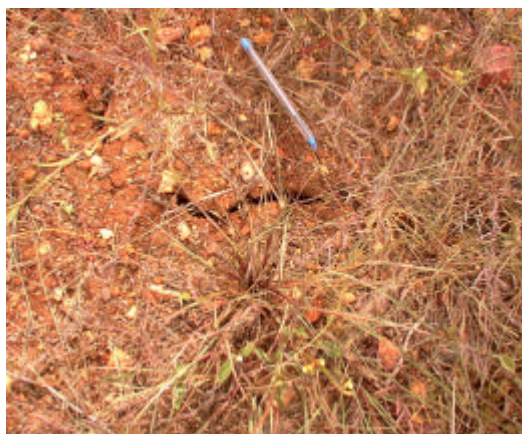
Figura 4. Gretas de ressecamento com cobertura vegetal.
