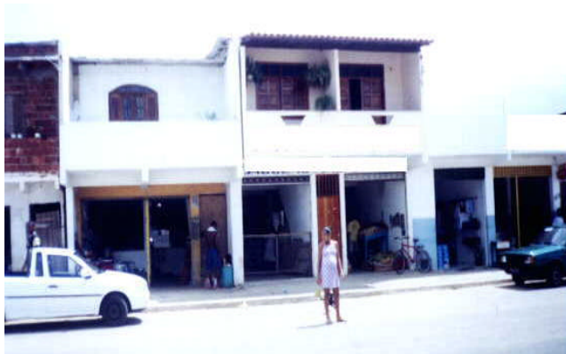
Figura 4 – Av Central - (pavimentação e comércio) Foto: Moreira.G.L
