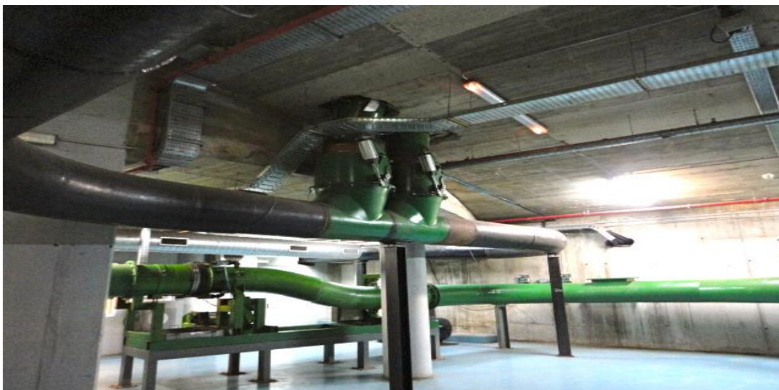
Figura 8 - Tubulações subterrâneas onde os resíduos são transportados a vácuo
