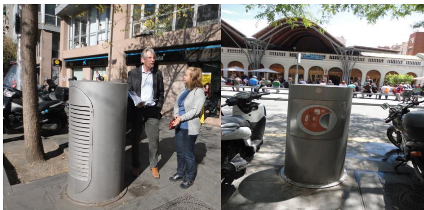
Figura 6 – Sistema “neumática” de coleta seletiva no Mercado Santa Caterina na cidade de Barcelona, visita monitorada pelo representante da ENVAC
