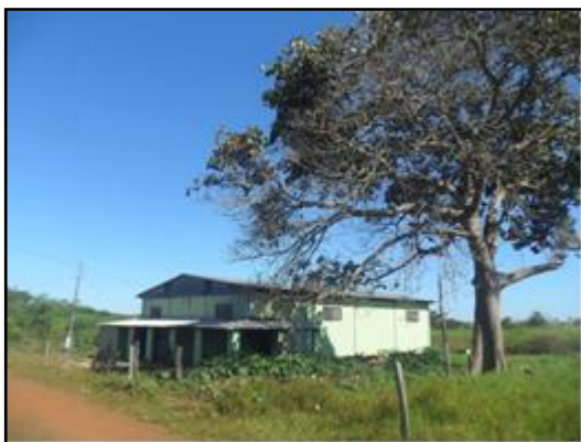
Figura 1 - Prédio da agroindústria de beneficiamento da mandioca.
