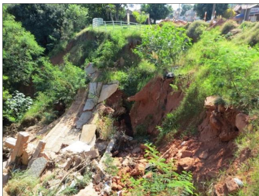
Figura 5. Setor de risco a erosão no centro de Parapuã.
