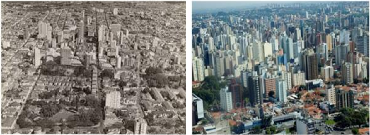
Figura 4 - Vista aérea da cidade de Campinas nas décadas de 1970 e 2010, evidenciando o adensamento populacional na área urbana.
