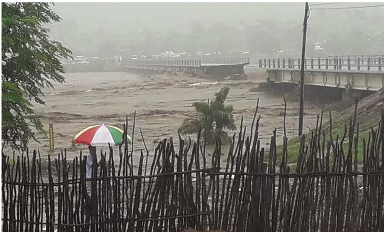
Figura 7 - Destruição dos tabuleiros da ponte, sobre o rio Revubuè. Fonte: Rádio Moçambique (25/01/2022)
