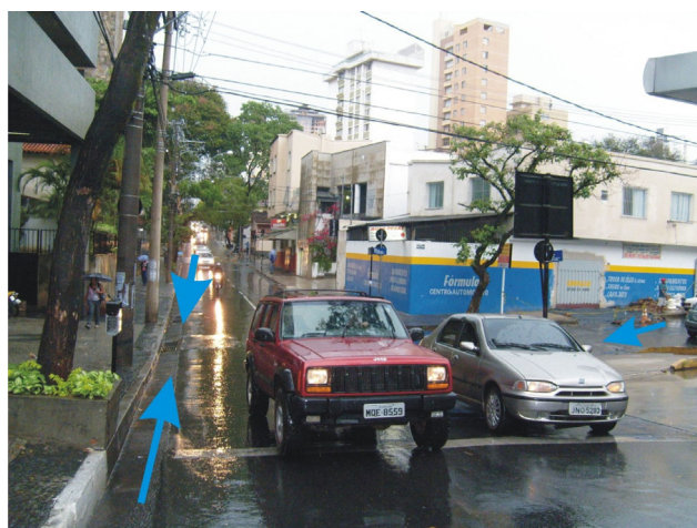
FIGURA 8. Rua Joaquim Murtinho, esquina com Av. Prudente de Moraes. Observar que os veículos estão em posição de subida diante da faixa branca. As setas azuis demonstram a concavidade e a direção do fluxo da água. (Foto – Patrícia E. Reis, Outubro 2010).
