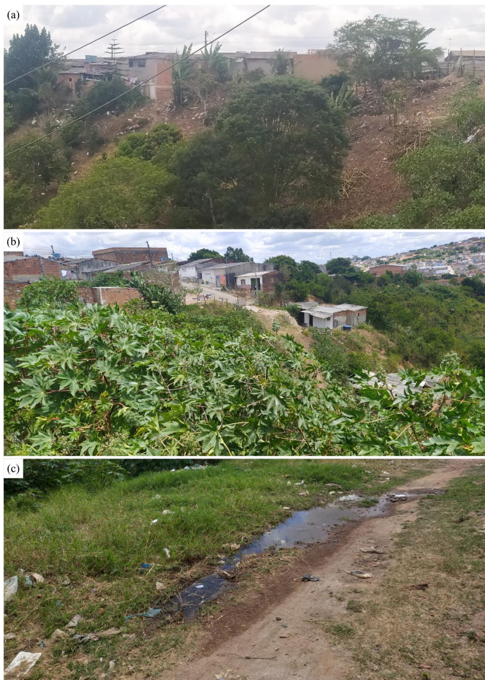
Figura 5. (a) encosta recoberta por aterro e acúmulo de lixo, com sustentação de algumas arbóreas e residências construídas em área de cabeceira; (b) encosta de cabeceira com alta declividade e construções em área de suscetibilidade e solo descoberto ao
