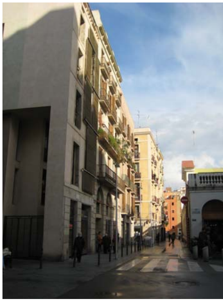
Foto N°3. Preservação da fachada original Rua Giralt el Pellisser . Fonte: Salcedo, junho de 2009
