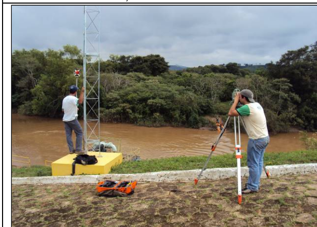
Figura 7. Foto Seção CHAPADÃO – Realização da Topobatimetria. Autor: Adriano Campos, Jan. 2010.
