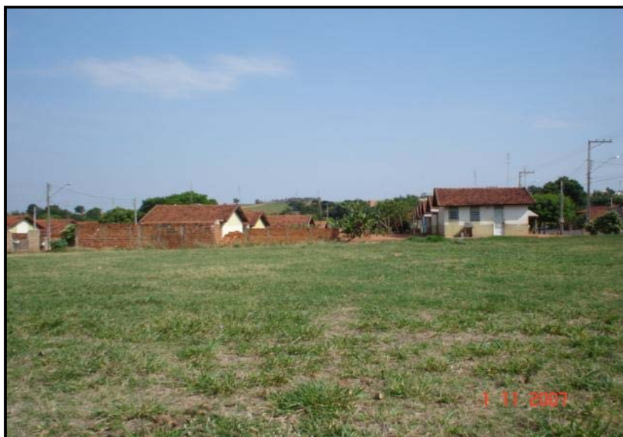
Foto 01 – Casas construídas em local de voçoroca aterrada. Fonte: Vitor Hiroshi Shintani, Nov/2007.
